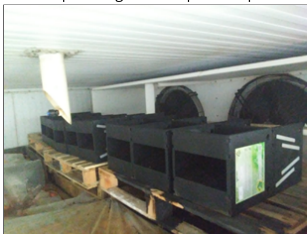
Figura 4 - Módulos com permanganato de potássio para absorção de etileno
